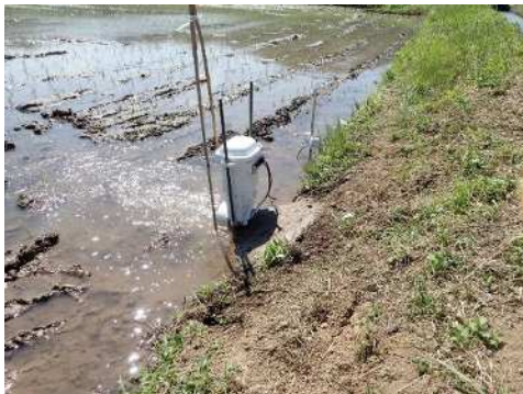
・ 水管理システムの機体
